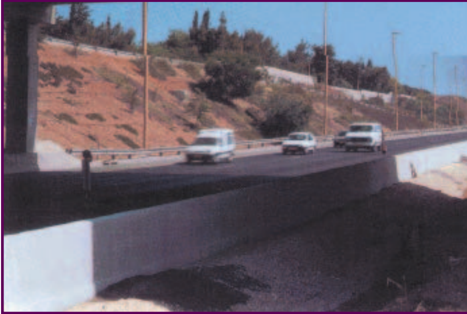
תרשים 12.14 - שילוב של סוללת עפר ומתרס מקשי בולע להפחתת רעש תחבורה
