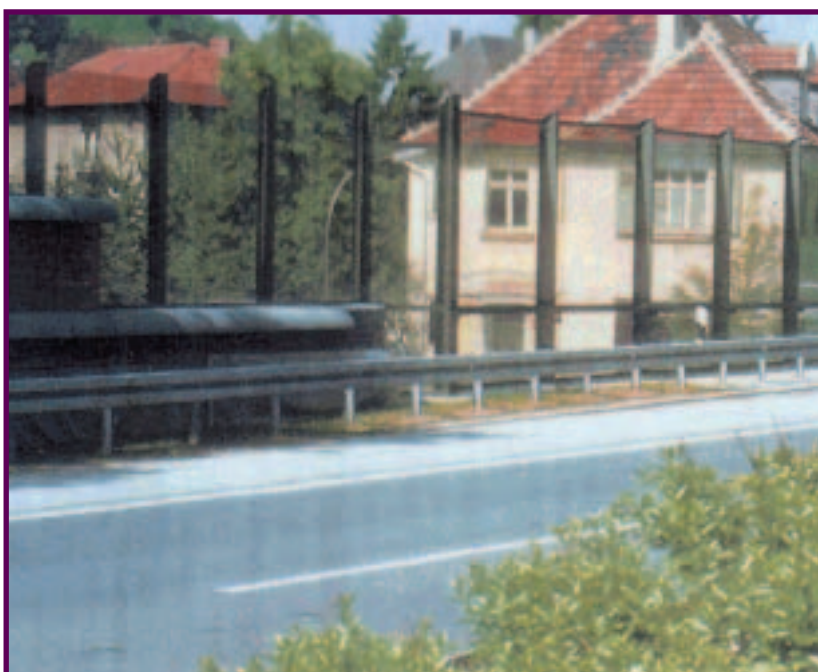
תרשים 12.11 – מתרס אקוסטי מפלסטיק שקוף להגנה בפני רעש תחבורה
