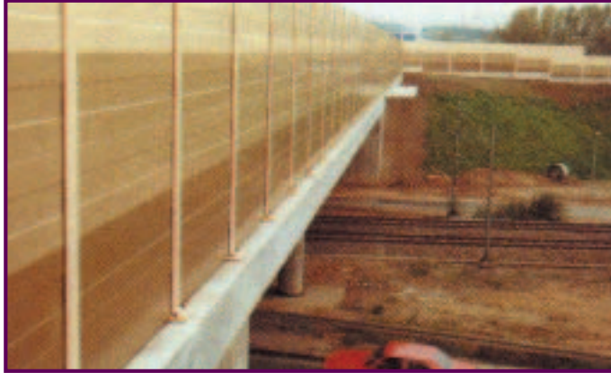
תרשים 12.15 – מתרס בולע משילוב אלומיניום מחורר וחומר בולע
