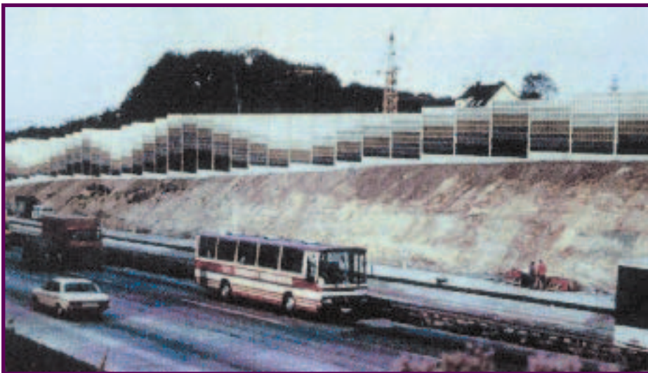
תרשים 12.14 - שילוב של סוללת עפר ומתרס מקשי בולע להפחתת רעש תחבורה
